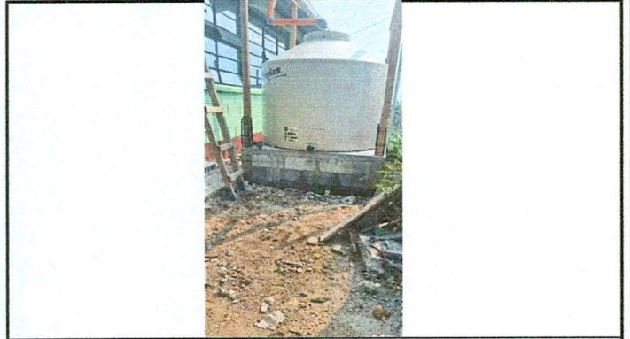
Foto 2: BASE DE TINACO NUEVO
