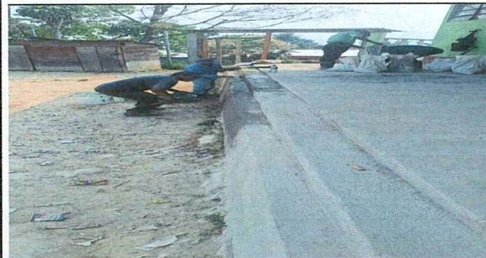
Foto 5: REPELLO DE CORREDOR
