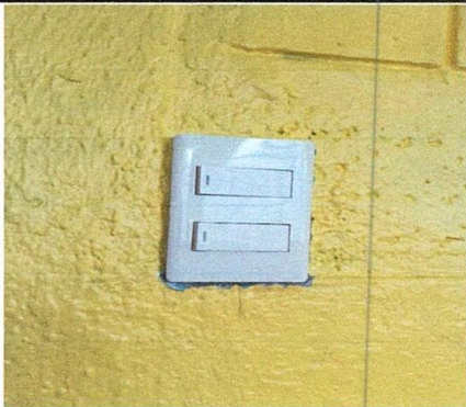
Foto 15: Sustitucion de interruptores dobles
