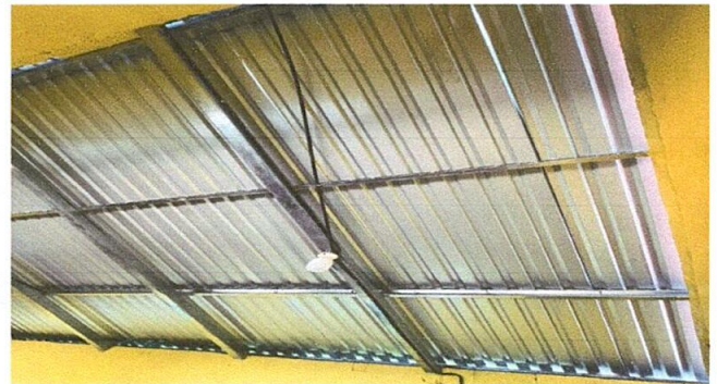
Foto 19: Sustitucion de ducto electrico + accesorios
