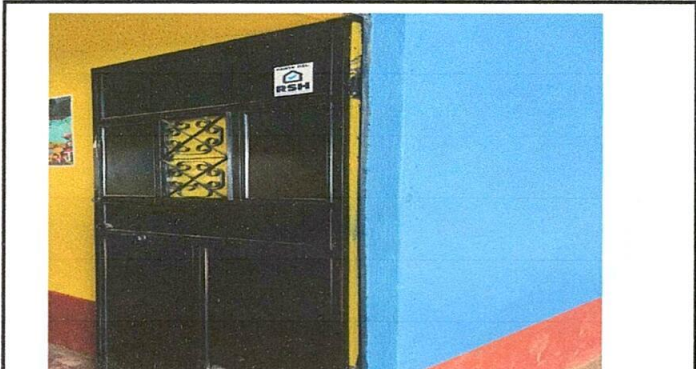
Foto 4: Mantenimiento a estructura (lijado, cambio de tubo, aplicación de pintura)
