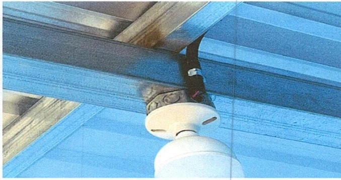
Foto 13: Sustitucion de plafoneras
