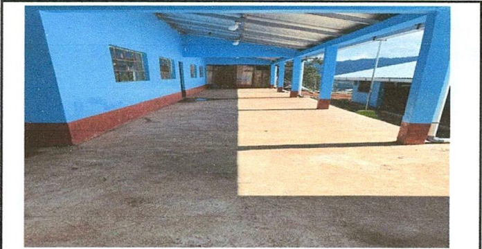
Foto 6: Sustitucion de piso de torta de concreto
