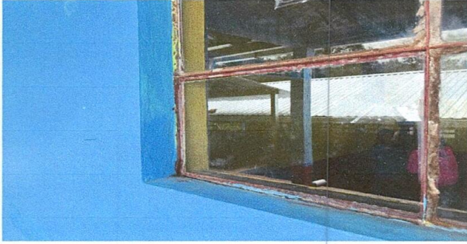
Foto 19: Sustitucion de vidrios a ventanas y puertas
