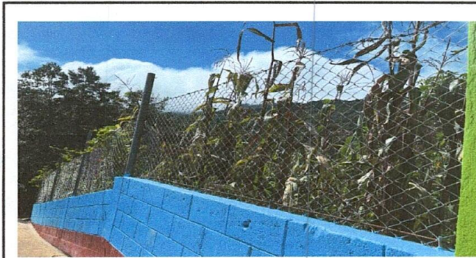
Foto 11: Reparacion de tubo HG y malla galvanizada
