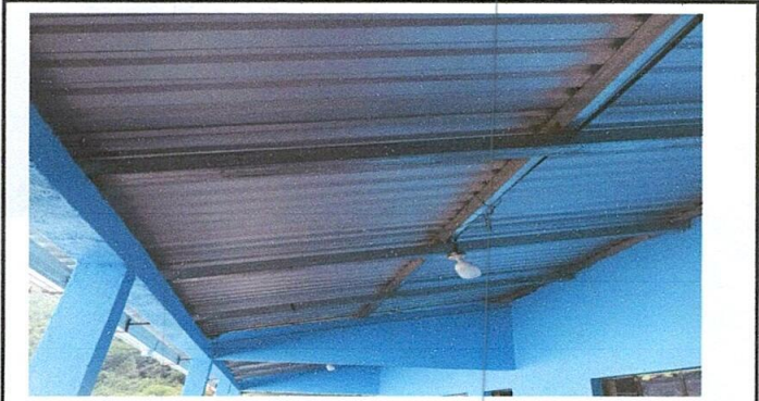
Foto 3: Sustitucion de estructura de soporte de madera por metalica
