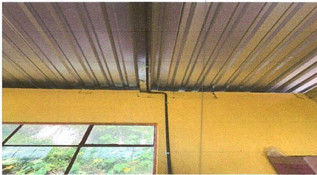
Foto 18: Reparacion de cableado electrico
