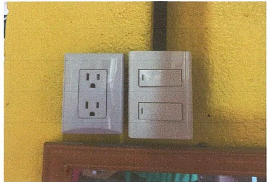
Foto 16: Sustitucion de tomacorrientes dobles
