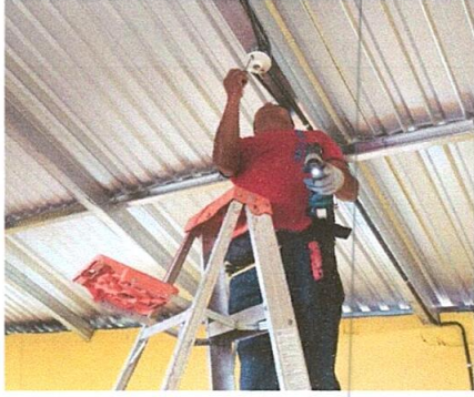
Foto 13: Sustitucion de plafoneras
