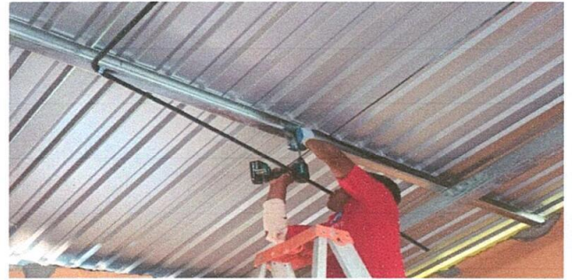
Foto 19: Sustitucion de ducto electrico + accesorios
