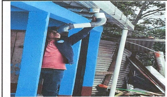
Foto 8: Reparacion de baja de agua pluvial tubo pvc 3
