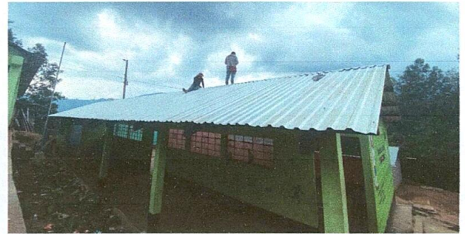
Foto 2: Sustitucion de capote de lamina para lamina troquelada
