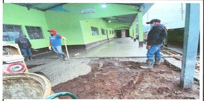
Foto 6: Sustitucion de piso de torta de concreto
