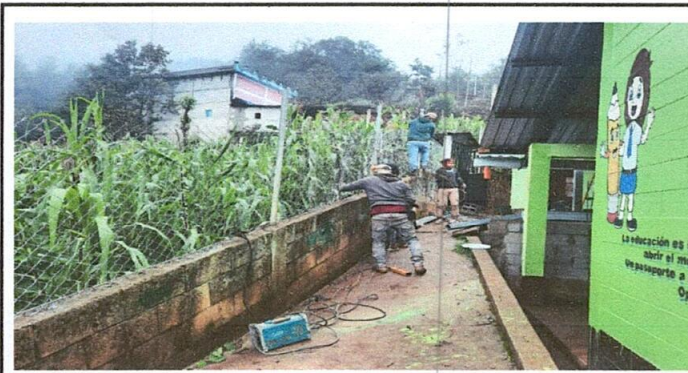
Foto 11: Reparacion de tubo HG y malla galvanizada
