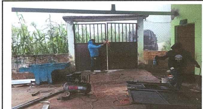
Foto 10: Mantenimiento a porton de metal
