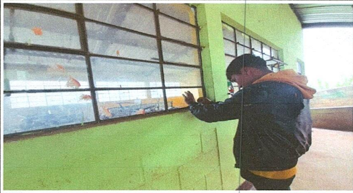
Foto 19: Sustitucion de vidrios a ventanas y puertas
