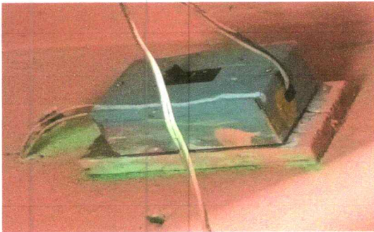
Foto 17: Sustitucion de flipones
