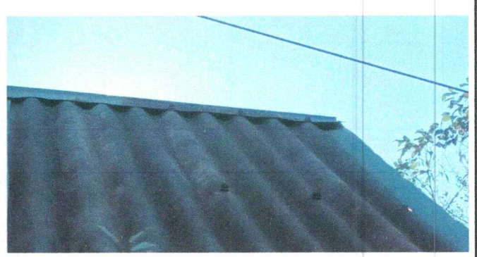
Foto 2: Sustitucion de capote de lamina para lamina troquelada
