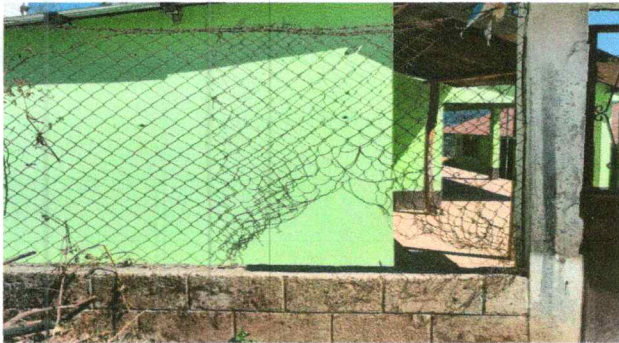
Foto 11: Reparacion de tubo HG y malla galvanizada
