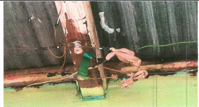
Foto 18: Reparacion de cableado electrico
