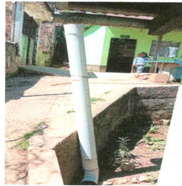
Foto 8: Reparacion de baja de agua pluvial tubo pvc 3
