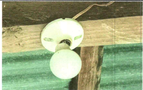
Foto 12: Sustitucion de lamparas tipo led
