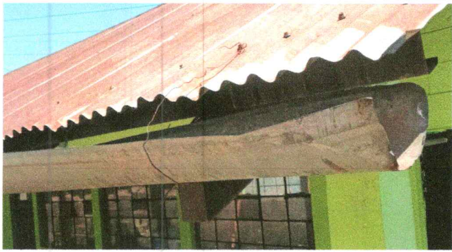
Foto 7: Sustitucion de canal de metal
