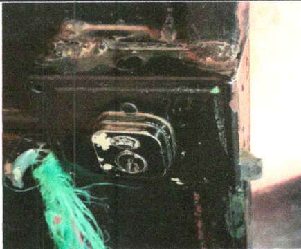
Foto 5: Sustitucion de chapa
