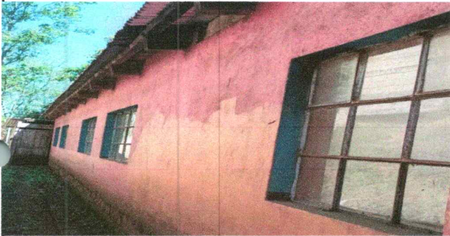
Foto 9: Pintura en muros exteriores e interiores
