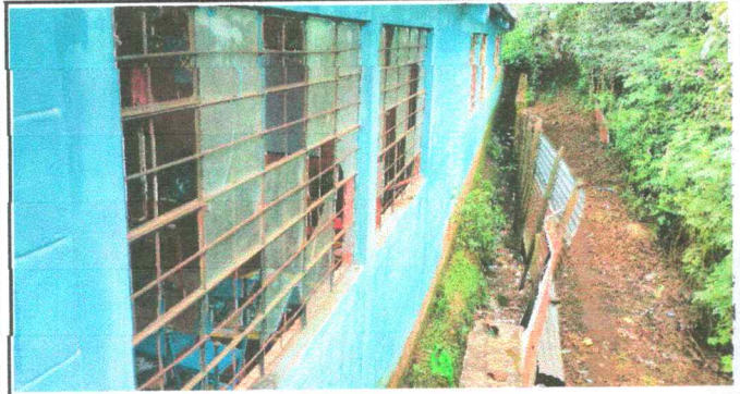
Foto 1: sustitución de vidrios y mejoramiento con balcones
