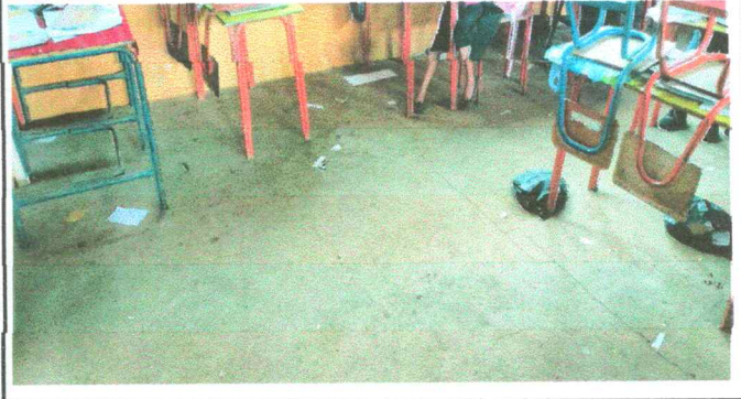
Foto 2: sustitución de piso por piso de granito
