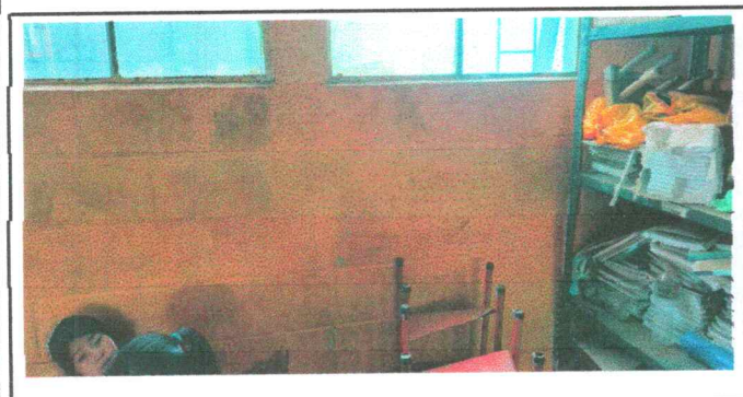
Foto 5: pintura en muros interiores
