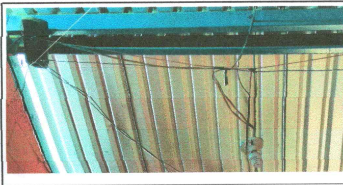
Foto 6: Reparación de cableado eléctrico
