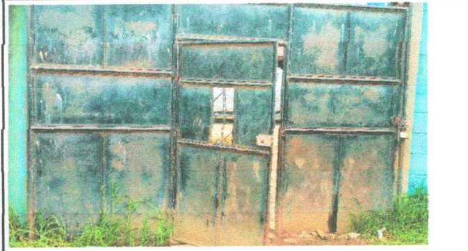
Foto 4: sustitución de portón
