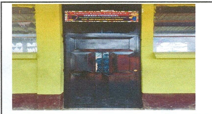
Foto 3: sustitución de puerta
