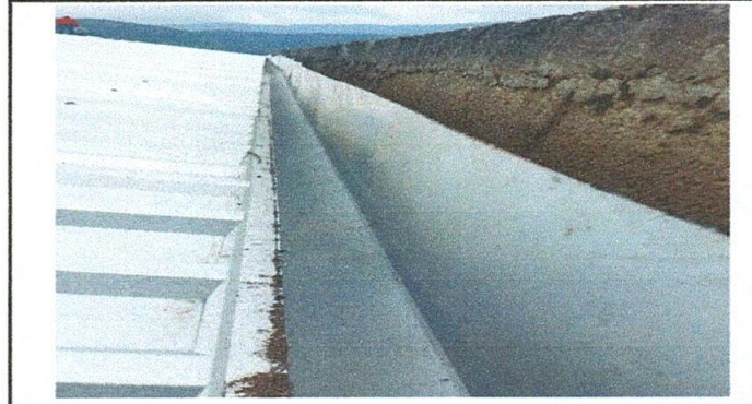
Foto 2: sustitución de canal de metal
