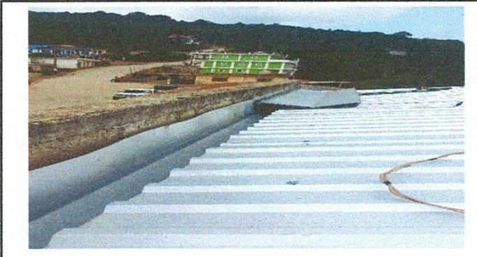
Foto 2: sustitución de canal de metal
