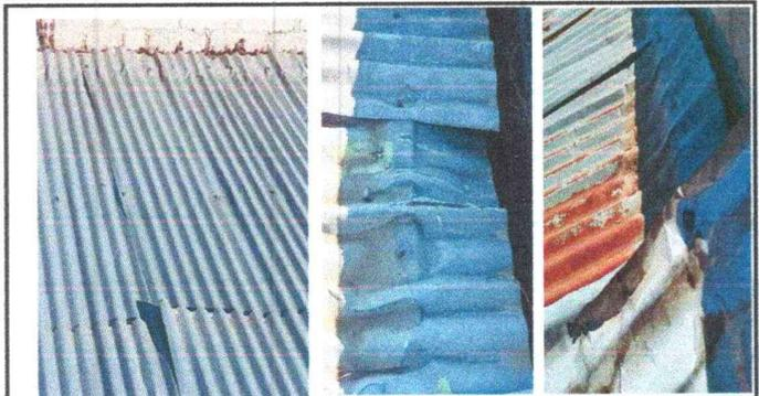
Foto 1: Sustitución de lámina, por lámina troquelada aluinc calibre 26 y sustitución de elementos de fijación.
