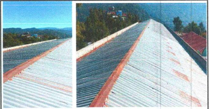
Foto 2: Sustitución de capote de lámina troquelada
