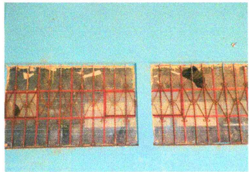
Foto 2: SUSTITUCION DE VIDRIOS
