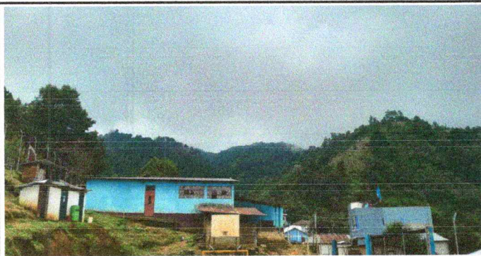
Foto 3: PINTURA DE MUROS EXTERIORES DE AULAS
