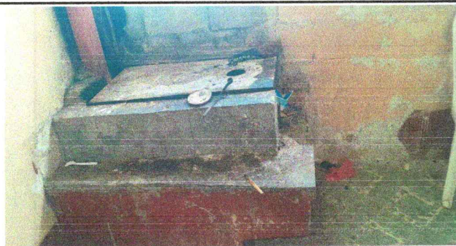
Foto 5: SUSTITUCION DE PLANCHA DE LA COCINA
