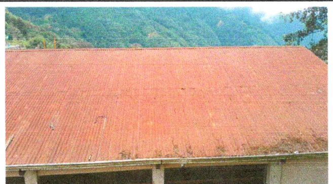
Foto 4: SUSTITUCION DE LAMINAS
