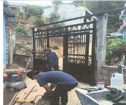
Foto 4: Sustitución de Portón informal por portón Metálico
