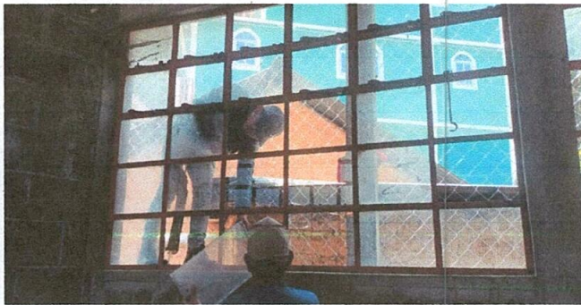
Foto 5: Sustitución de vidrios
