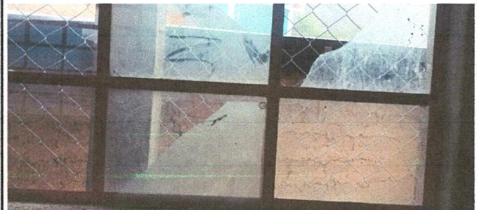
Foto 6: Sustitución de vidrios
