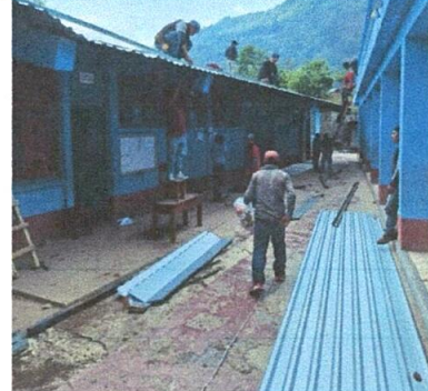
Foto 2: Sustitución de Lámina por lámina troquelada
