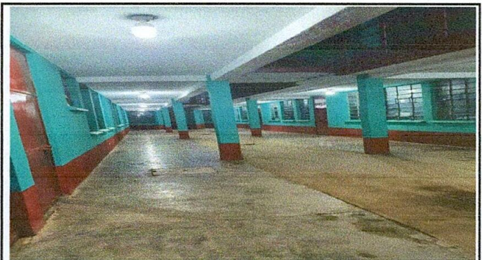
Foto 4: Finalización de mantenimiento a red de drenaje
