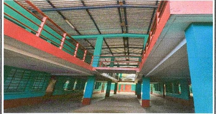
Foto 2: finalización del cambio de láminas
