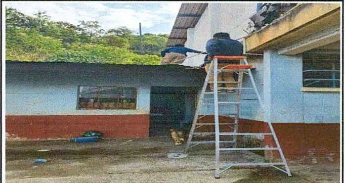
Foto 4: Sustitución de lámina
