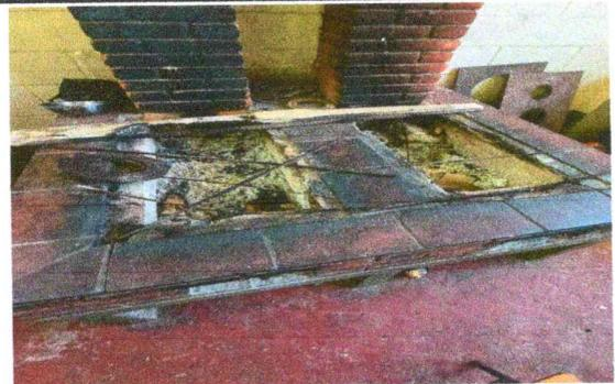
Foto 6: Sustitución de planchas
