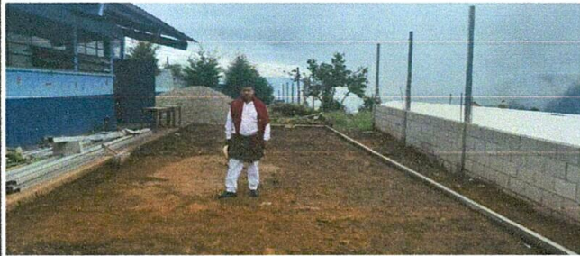
Foto1: La tierra planada y nivelada.
