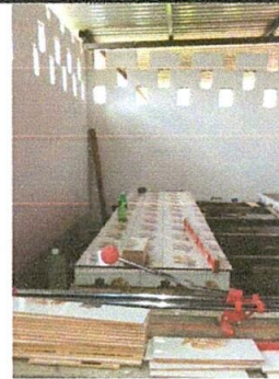
Foto 4: Colocación de cerámicos en las mesas de la cocina.
