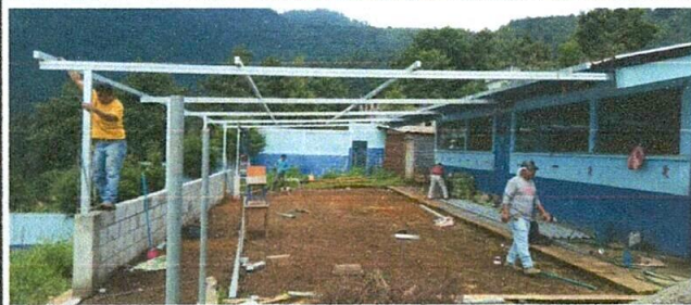
Foto 3: Colocación de las estructuras metálicas para el techo
