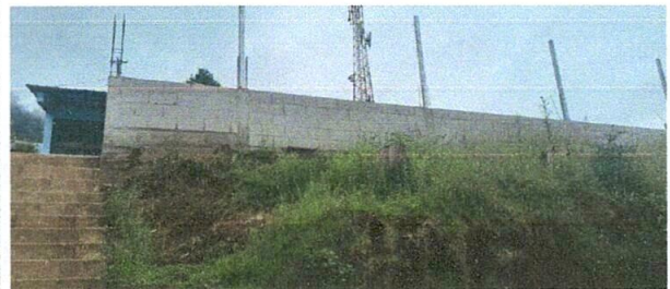
Foto 6: Muro perimetral en proceso.
