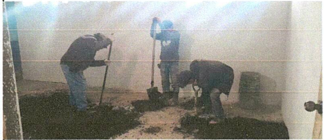
Foto 2: Escarbación de tierra para la colocación de columnas de las mesas de cocina.
