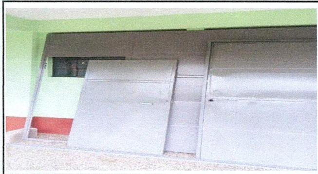
Foto 3: portón y puerta en proceso de samblaje
