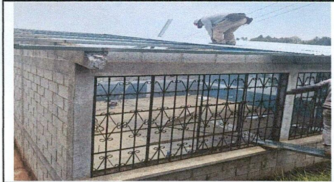
Foto1: Colocación de lámina troquelada y costaneras
