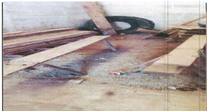
Foto 4: Piso torta de concreto
