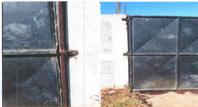
Foto 3: Sustitución de portón
