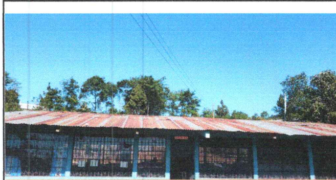
Foto 1: Sustitución de cubierta de aulas 166 M2 de lámina troquelada calibre 26
