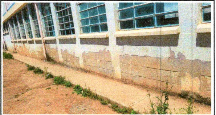
Foto 10: Repello en muros
