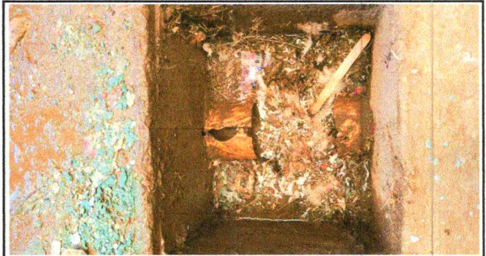
Foto 4: Sustitución de tubería de PVC línea principal aguas negras
