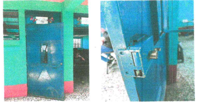
Mantenimiento de puertas de metal, chapas y pintura
