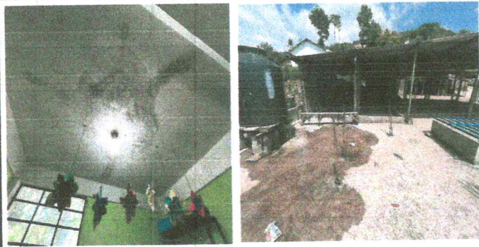
Mantenimiento de techo, por dentro y por fuera
