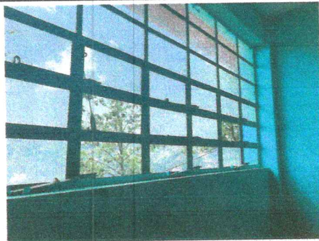
Mantenimiento de ventanas
