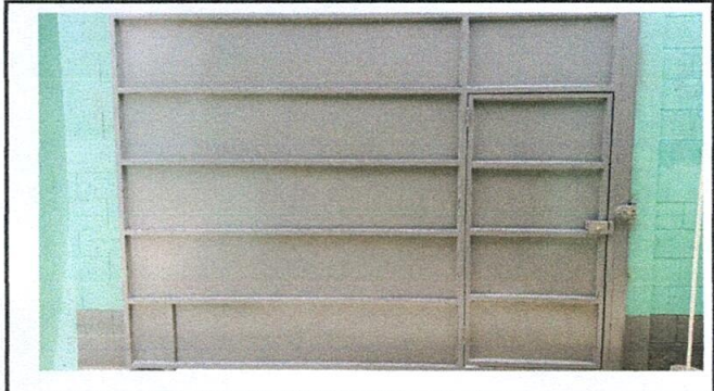
Foto1: PUERTAS DE METAL
