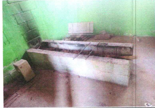
Foto 4. REPARACIÓN DE COCINA
