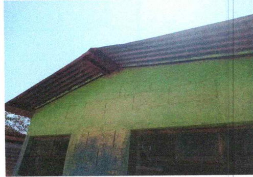
Foto 2. ESTRUCTURA DE TECHO
