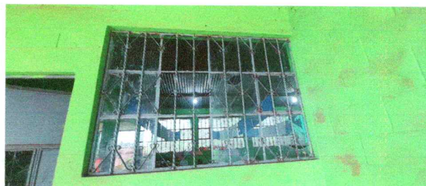
Foto 2: sustitucion de vidrios
