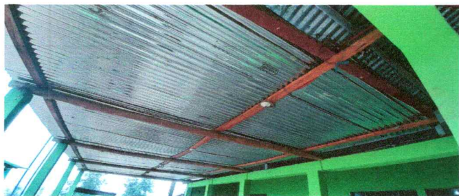
Foto 5: sustitución de estructura de madera por metal
