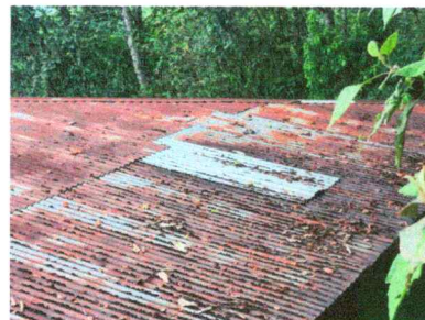
Foto 6: sustitución de laminas
