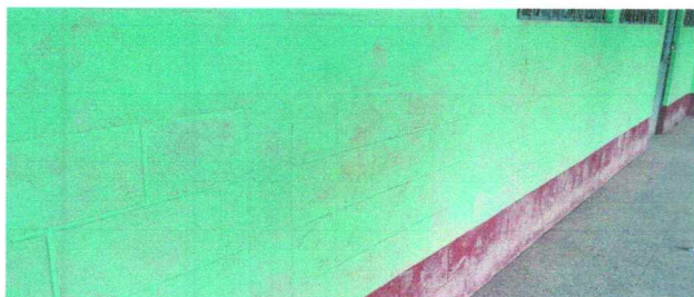
Foto 3: Pintura en muros exteriores e interiores
