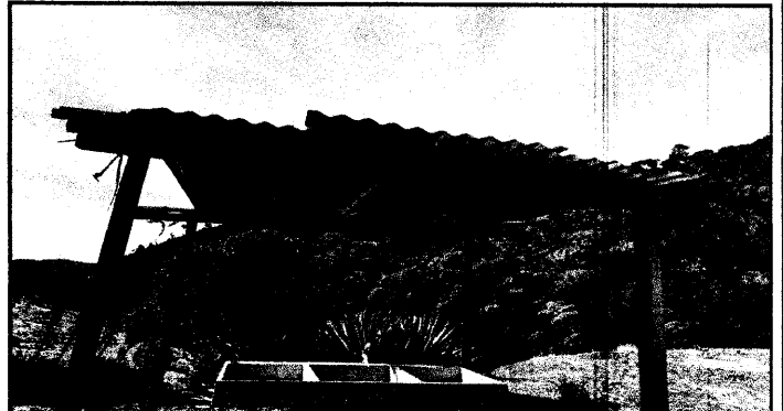
FOTO 2: SUSTITUCIÓN A ESTRUCTURA DE SOPORTE DE MADERA, POR METAL
