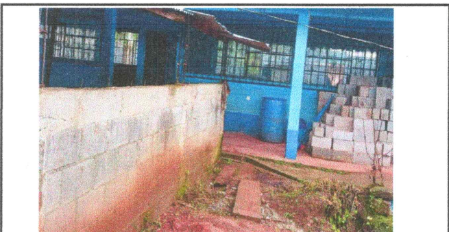
Foto 5: SUSTITUCION DE MURO PERIMETRAL DE BLOCK, MALLA Y TUBO HG
