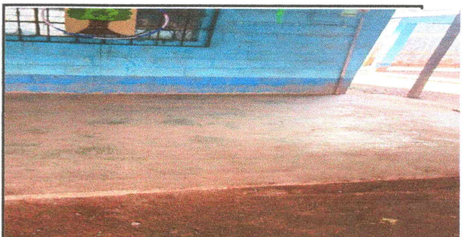
Foto 6: SUSTITUCION DE TORTA DE CONCRETO POR TORTA DE CONCRETO
