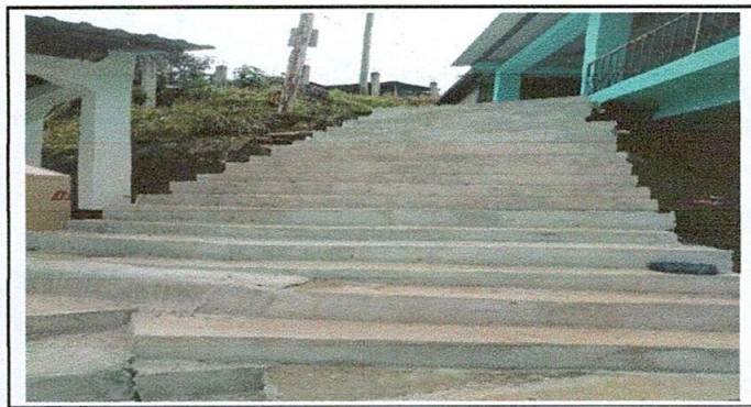
FOT 5: REPARACIÓN DE PLANCHA DE CONCRETO
