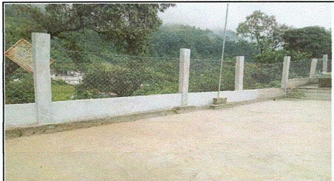
FOT 3: REPARACIÓN A MURO PERIMETRAL DE BLOCK
