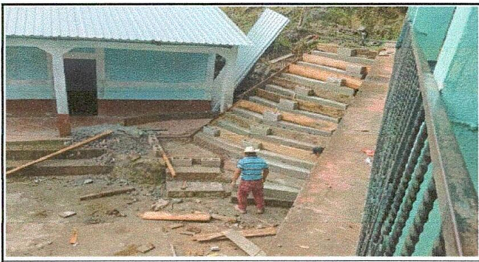
FOTO 5: REPARACIÓN DE PLANCHA DE CONCRETO
