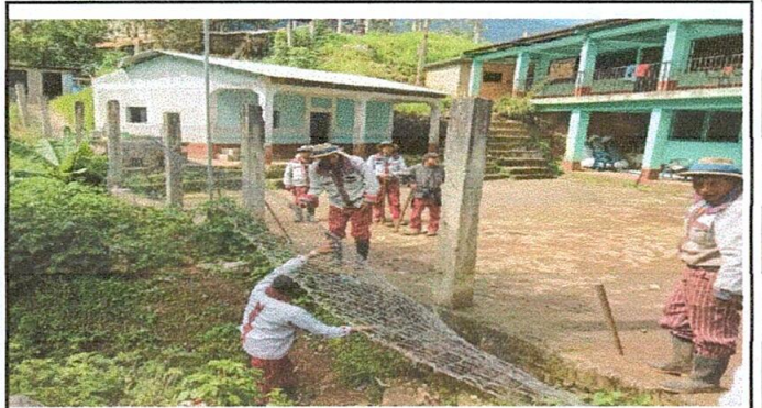
FOTO 4: REPARACIÓN DE MURO PERIMETRAL DE MALLA Y TUBO HG
