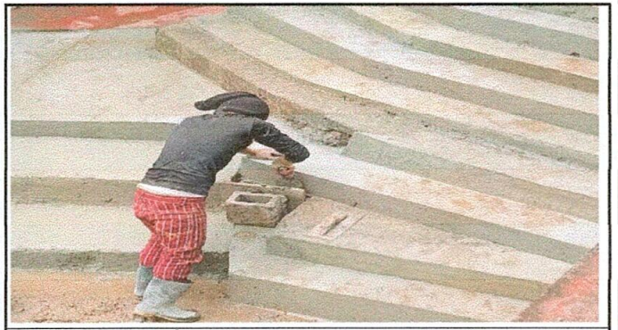
FOTO 6: REPARACIÓN DE PLANCHA DE CONCRETO EN PATIO
