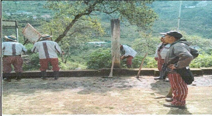
FOTO 1: REPARACIÓN DE CUNETA DE CONCRETO
