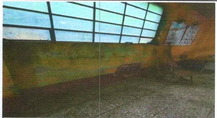
Foto 2: reparación de muro, por humedad.
