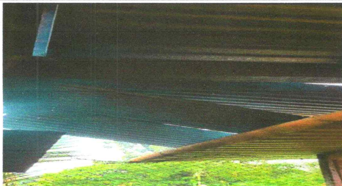
Foto7: sustitución de laminas de cocina
