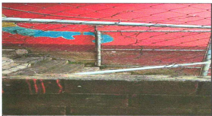
Foto 12: sustitución y reparación de mayas galvanizadas
