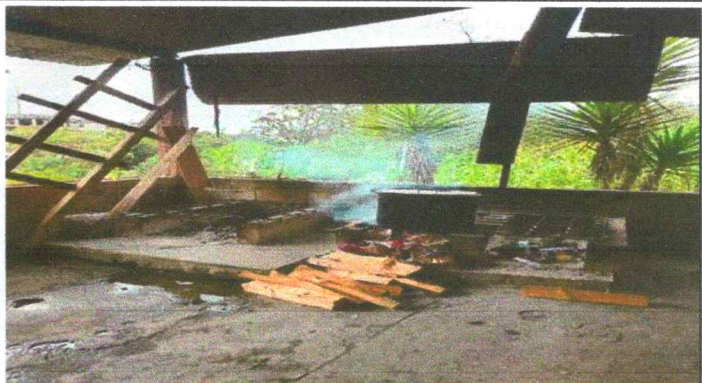
Foto 8: sustitución y reparación de laminas de cocina, cooredores y otras
