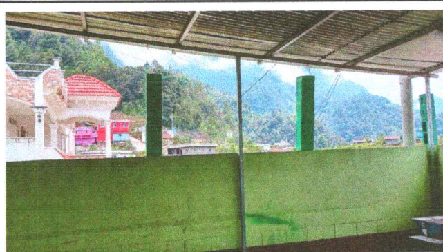
Foto 2: Sustitución de estructura de metal de ventana
