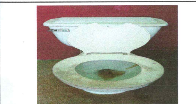
Foto 6: Sustitucion de inodoro
