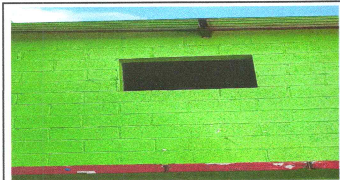
Foto1: Sustitución de estructura de metal de ventana
