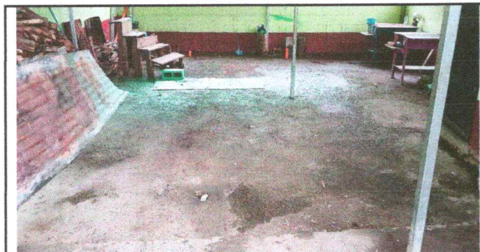
Foto 3: Sustitución de piso de granito
