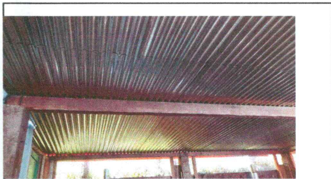
Foto 4: SUSTITUCION DE LAMINA Y ESTRUCTURA DE SOPORTE EN COCINA
