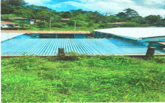
Foto1: SUSTITUCION DE LÁMINA POR LÁMINA TROQUELADA
