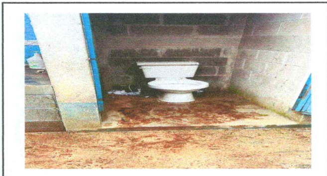
Foto 2: MEJORAMIENTO DE SANITARIOS
