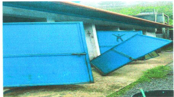
Foto 6: REPARACION DE PUERTAS DE SANITARIOS
