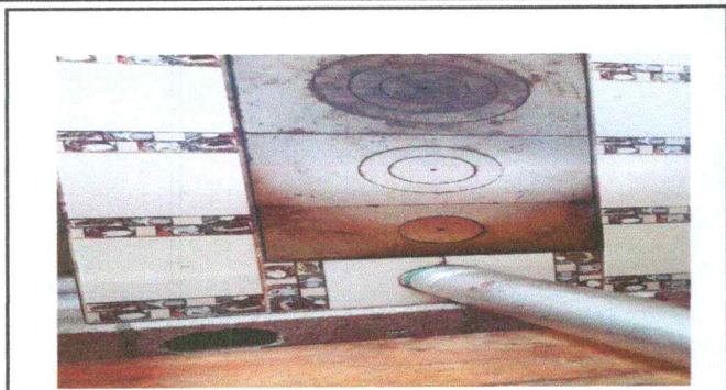
Foto1: SUSTITUCION DE PLANCHA DE METAL PARA ESTUFA RURAL
