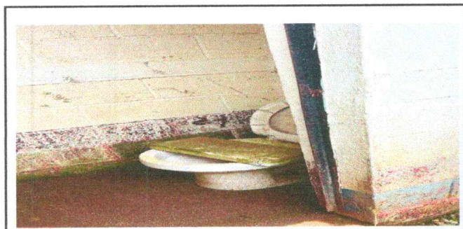
Foto 3: SUSTITUCION DE INODOROS
