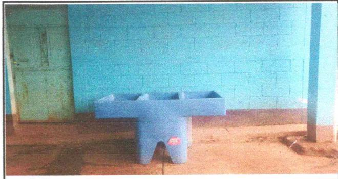
Foto 9: SUSTITUCIÓN DE PILA PLASTICA DE UN LAVADERO
