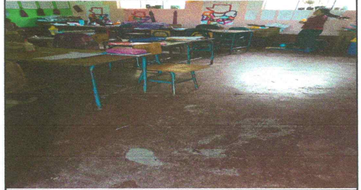
Foto 2: Piso de las aulas del centro educativo
