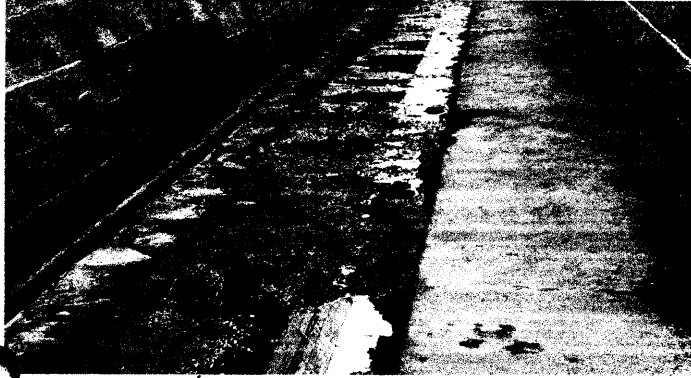
FOTO 1: REPARACIÓN DE CUNETA/ BANQUETA DE CONCRETO
