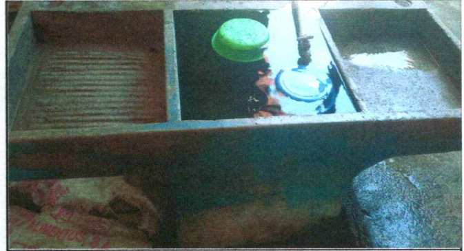
Foto 2: Sustitución de pila de cemento de dos lavaderos
