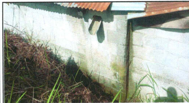
Foto 3: Mejoramiento de pared de block
