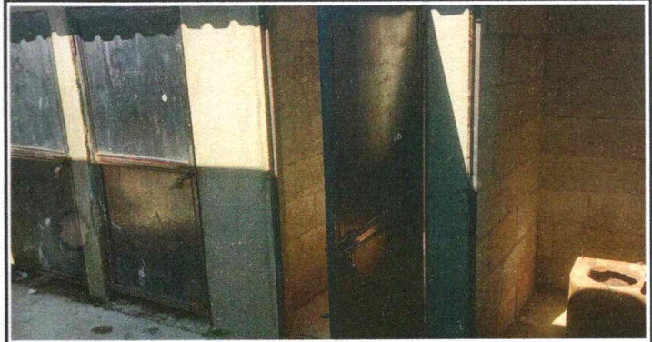
Foto 8: Sustitución de letrinas por baños labables
