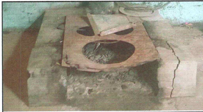
Foto 1: Sustitución de plancha de metal de 3 hornillas
