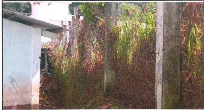
Foto 10: Reparación de muro de contención
