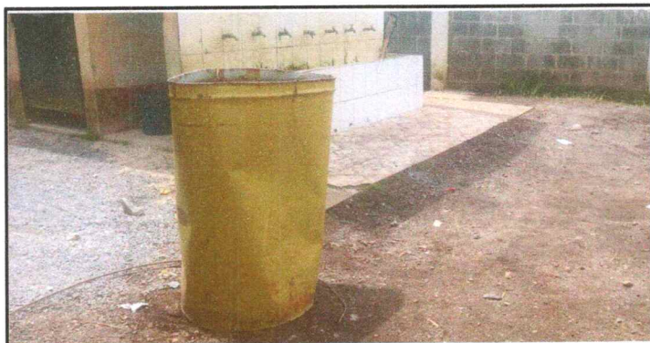
Foto 11: Sustitución de depósito de agua 1700 lt,
