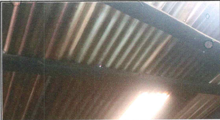
Foto 7: Sustitución de estructura de soporte de madera, por metal
