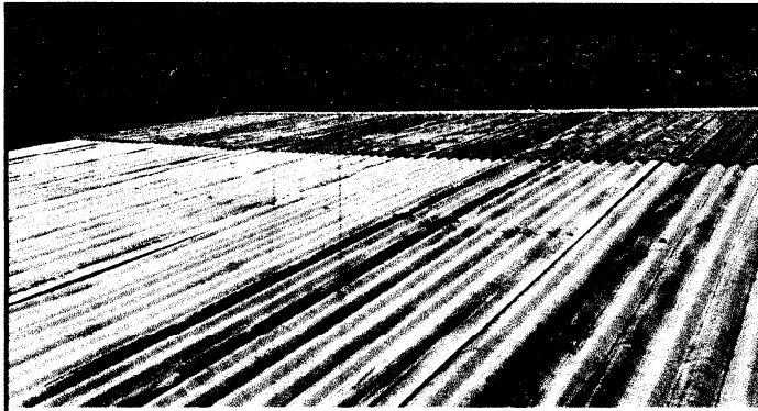
FOTO 1: SUSTITUCIÓN DE LÁMINA
