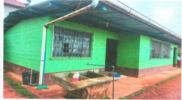
Foto 10: SUSTITUCIÓN DE CANALES Y BAJADAS DE AGUA
