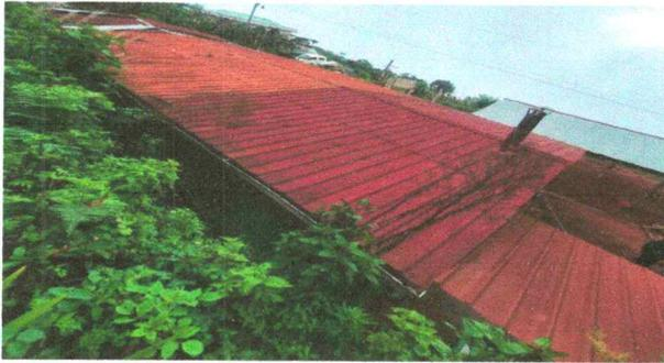
Foto1: SUSTITUCIÓN DE TECHO DE LÁMINA
