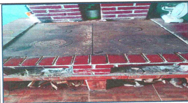
Foto 9: sustitucion de plancha de metal
