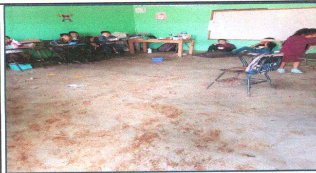
Foto 3: sustitucion de piso ceramico
