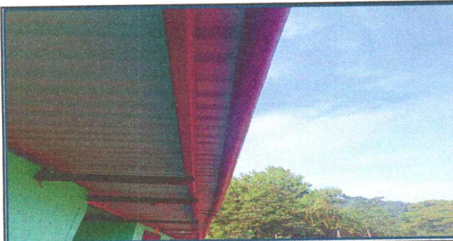
Foto 11: sustitucion de canal PVC
