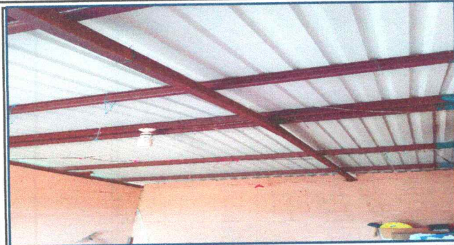
Foto7: Sustitución de estructura de soporte de metal
