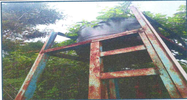
Foto13: Sustitución de deposito de agua
