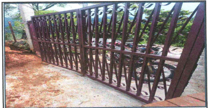
Foto 6: mantenimiento a portones de metal
