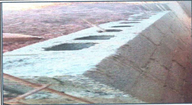
Foto 1: Reparación de muro perimetral
