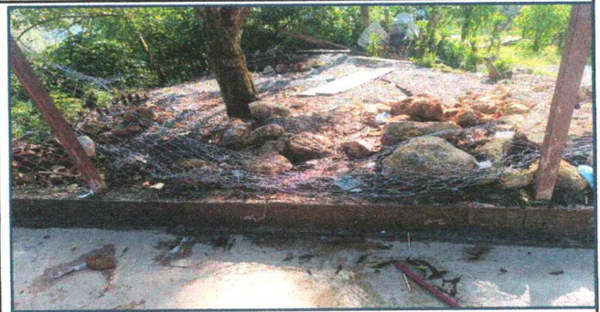
Foto 2: Reparación de enmallado
