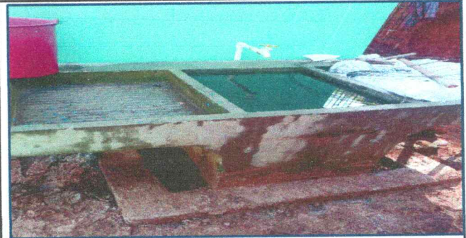
Foto 8: sustitucion de pila de cemento de dos lavaderos
