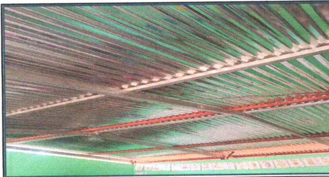
Foto 5: sustitución de lámina por lámina troquelada
