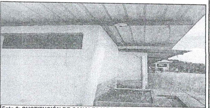
Foto 6: SUSTITUCIÓN DE CANALES Y BAJADA DE AGUA PLUVIAL
