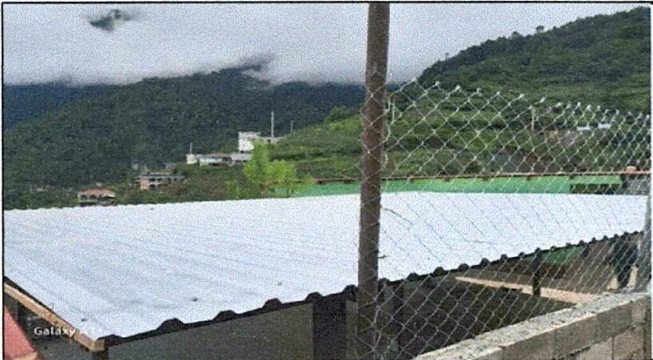
FOTO 1: SUSTITUCIÓN DE LAMINA
