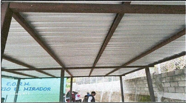
FOTO 2: SUSTITUCIÓN DE ESTRUCTURA DE MADERA, POR METAL
