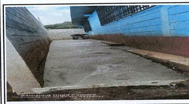
Foto 5: REPARACIÓN DE PISO DE TORTA DE CEMENTO
