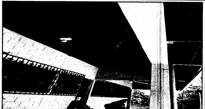
FOTO 2: MANTENIMIENTO DE ESTRUCTURA DE METAL
