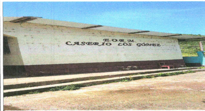
Foto 3: PINTURA DE MUROS EXTERIORES
