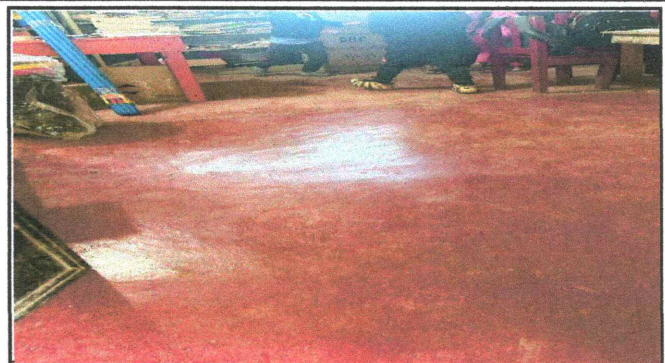
Foto 2: SUSTITUCION DE PISO POR PISO GRANITO
