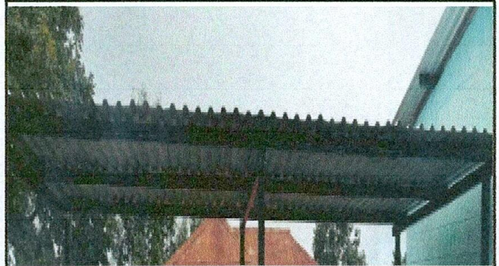
FOTO 2: SUSTITUCIÓN DE ESTRUCTURA DE MADERA POR METAL
