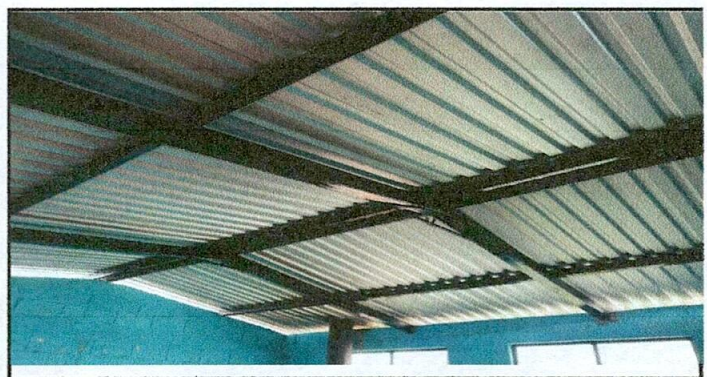
FOTO 6: SUSTITUCIÓN DE ESTRUCTURA DE MADERA POR METAL
