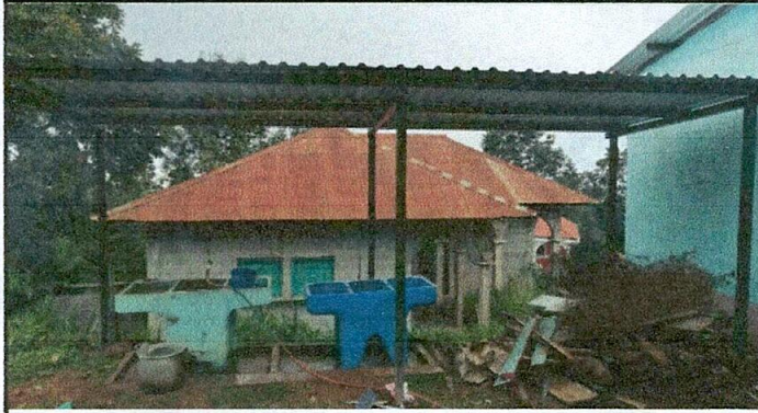
FOTO 1: SUSTITUCIÓN DE LAMINA
