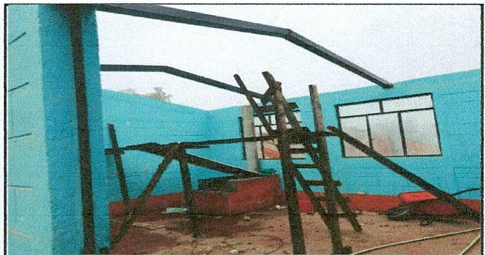
FOTO 6: SUSTITUCIÓN DE ESTRUCTURA DE MADERA POR METAL
