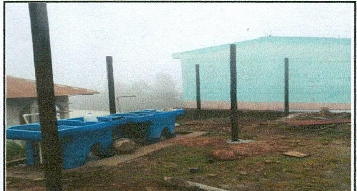
FOTO 2: SUSTITUCIÓN DE ESTRUCTURA DE MADERA POR METAL
