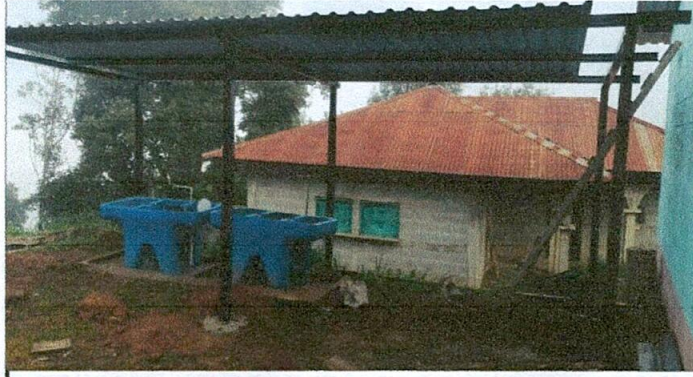
FOTO 1: SUSTITUCIÓN DE LAMINA
