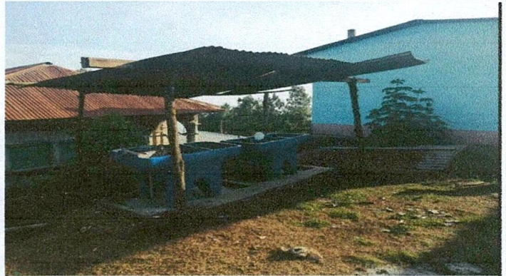
FOTO 2: SUSTITUCIÓN DE ESTRUCTURA DE MADERA POR METAL
