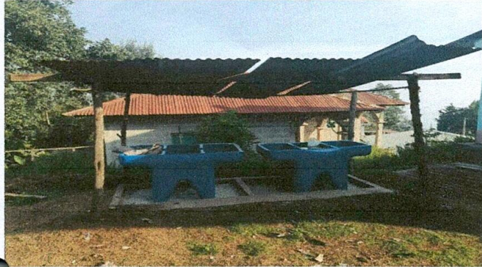
FOTO 1: SUSTITUCIÓN DE LAMINA
