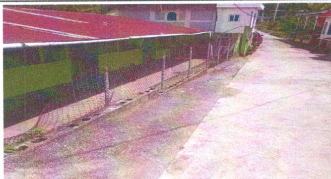
Foto1: SUSTITUCION DE LAMINA
