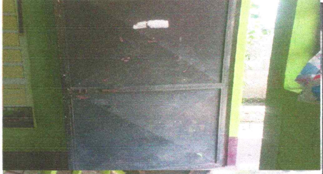
Foto 10: PUERTAS DE METAL (mantenimiento de estructura lijado, aplicación de pintura)
