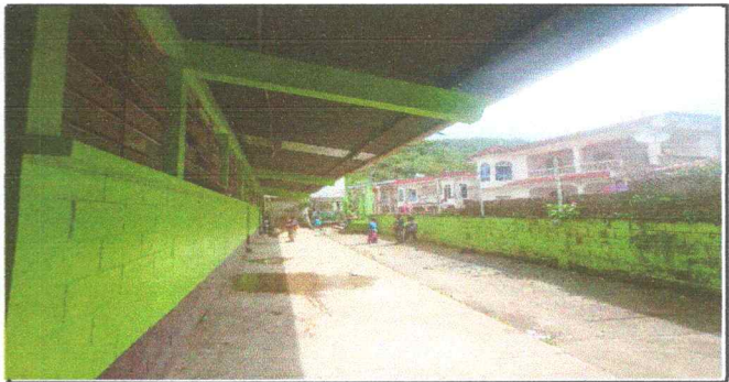
Foto 11: PINTURA EN PAREDES EXTERIORES
