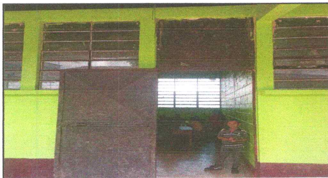
Foto 9: PUERTAS DE METAL (mantenimiento de estructura lijado, aplicación de pintura)
