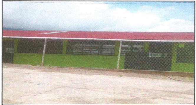
Foto 14: SUSTITUCION DE MALLA GALVANIZADA
