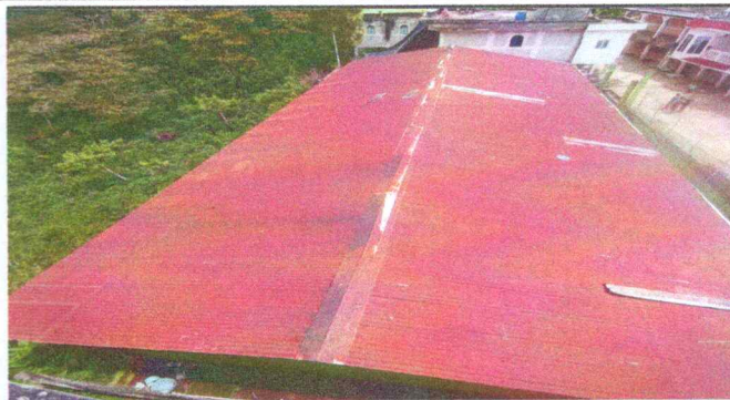
Foto 2: SUSTITUCION DE LAMINA
