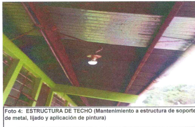
Foto 3: ESTRUCTURA DE TECHO (Mantenimiento a estructura de soporte de metal, lijado y aplicación de pintura))
