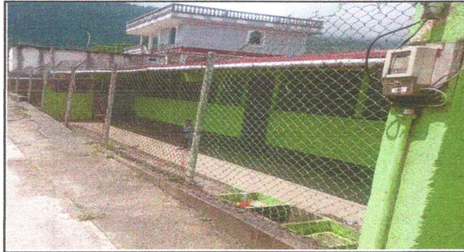
Foto 13: SUSTITUCION DE MALLA GALVANIZADA
