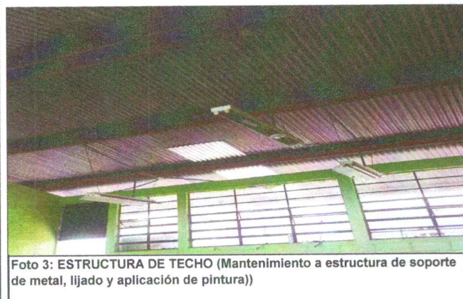
Foto 4: ESTRUCTURA DE TECHO (Mantenimiento a estructura de soporte de metal, lijado y aplicación de pintura)
