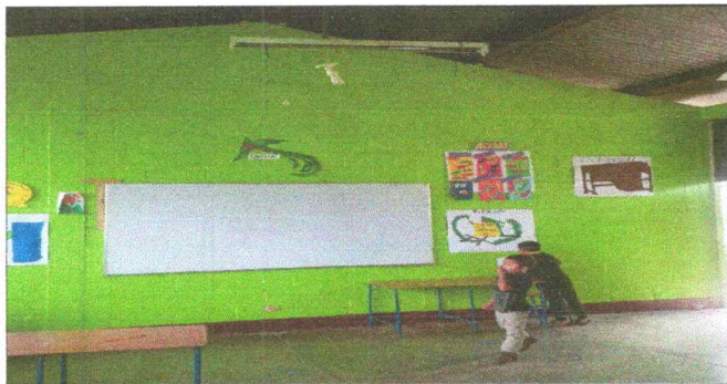
Foto 11: PINTURA EN PAREDES INTERIORES
