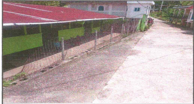
Foto 7: SUSTITUCION DE CANAL
