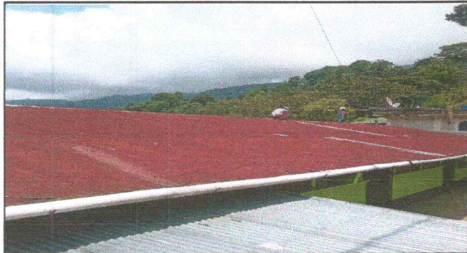
Foto 7: SUSTITUCION DE CANAL
