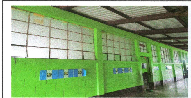
Foto 3: SUSTITUCIÓN DE VENTANAS DE METAL CON VIDRIOS
