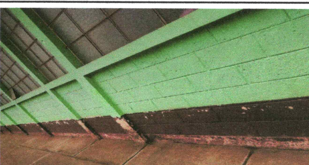
Foto 4: PINTURA EN MURO
