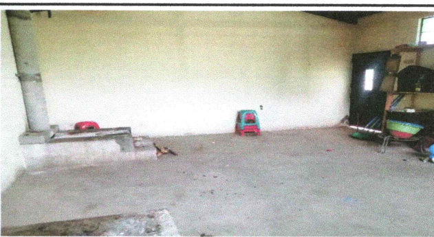
Foto 6: SUSTITUCIÓN DE PISO DE CONCRETO POR PISO GRANITO DE COCINA
