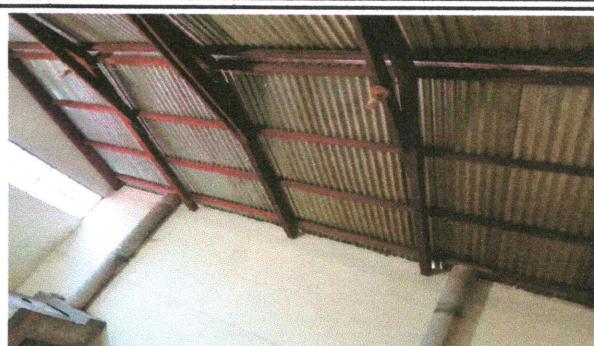
Foto 2: MANTENIMIENTO A ESTRUCTURA DE SOPORTE DE METAL
