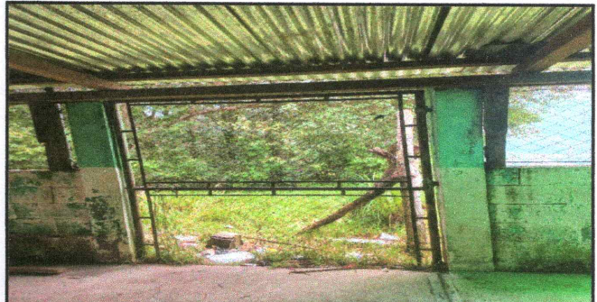
Foto 8: SUSTITUCIÓN DE PORTÓN
