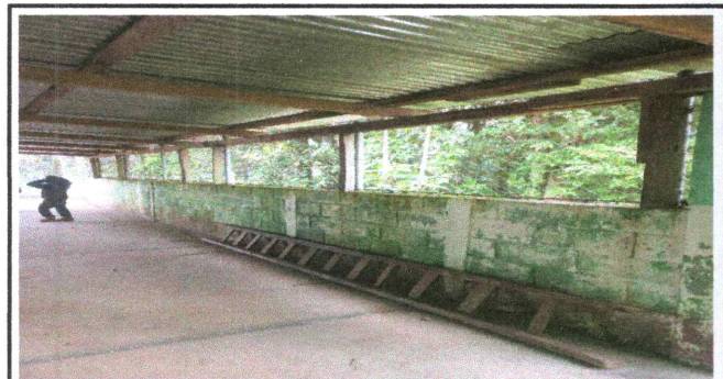
Foto 5: PINTURA EN MURO
