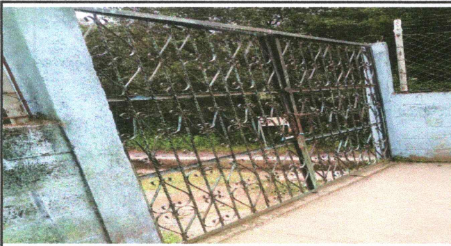
Foto 9: MANTENIMIENTO DE PORTÓN
