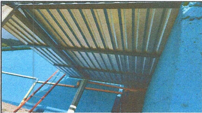
Foto 3: Sustrucción de soporte de madera, por metal
