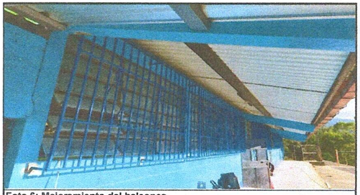
Foto 6: Mejoramiento del balcones
