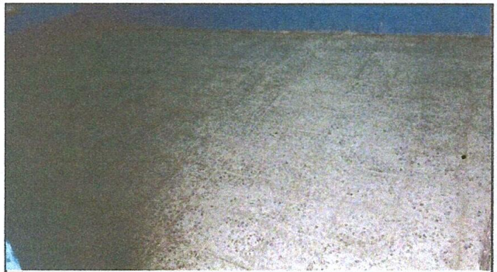
Foto 4: Sustrucción de piso de granito
