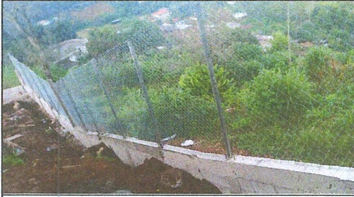
Foto 1: Sustrucción de muro perimetral
