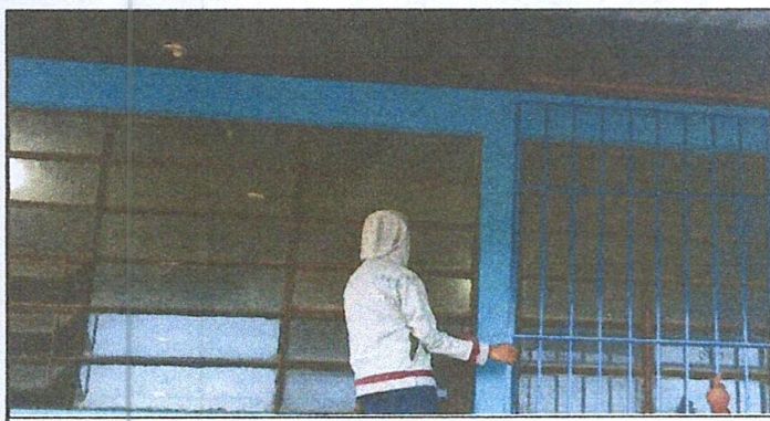
Foto 5: Mejoramiento del balcones
