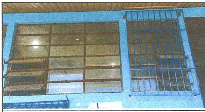
Foto 6: Mejoramiento del balcones
