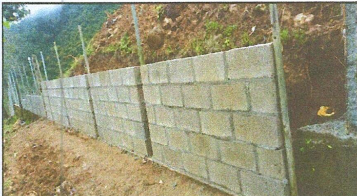
Foto 1: Sustitución de muro perimetral
