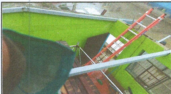
Foto 3: Sustitución de soporte de madera, por metal
