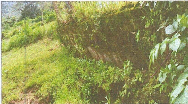
Foto 1: Sustrucción de muro perimetral
