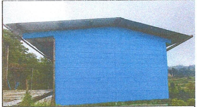
Foto 2: Sustrucción de lámina, por lámina troquelada aluzinc
