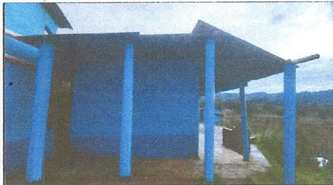
Foto 3: Sustrucción de soporte de madera, por metal
