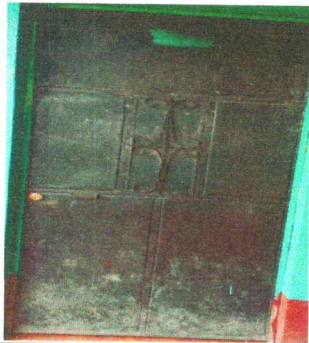
Foto 3: Sustrucción de puertas de metal a puertas de metal de 1 metro de ancho
