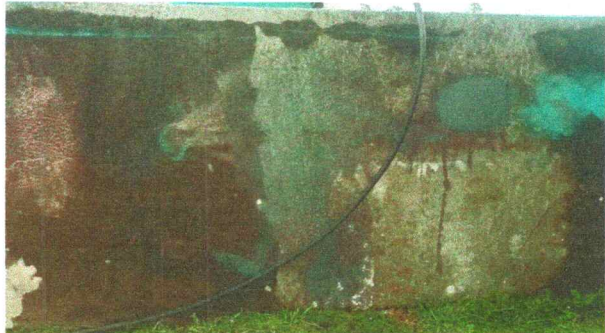
Foto 13: Sustrucción de depósito de agua 1700 lt
