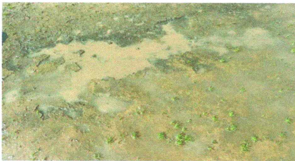
Foto 11: Reparación de planchas de concreto de patio
