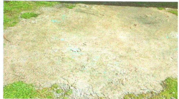
Foto 10: Reparación de planchas de concreto de patio
