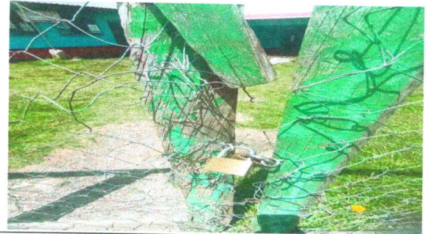
Foto 2: Sustrucción de portón de malla y madera a portón de malla y tubo galvanizado de dospulgadas de 4 mts de ancho con puerta central.
