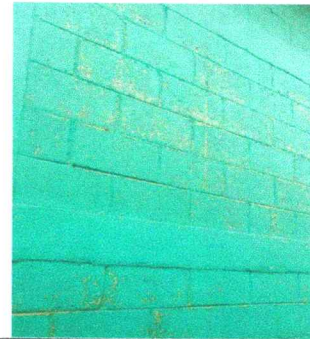
Foto 8: Pintura en muros exteriores e interiores
