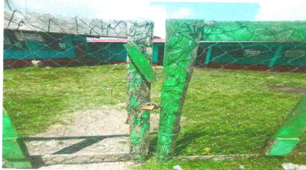
Foto 1: Sustrucción de portón de malla y madera a portón de malla y tubo galvanizado de dospulgadas de 4 mts de ancho con puerta central.
