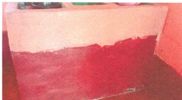
Foto 16: Mantenimiento de pila de concreto de dos lavaderos con impermeabilizante
