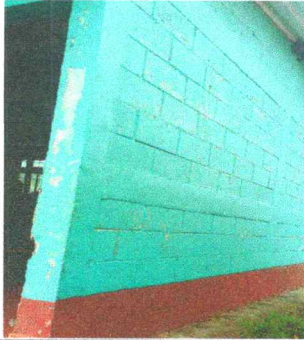
Foto 7: Pintura en muros exteriores e interiores
