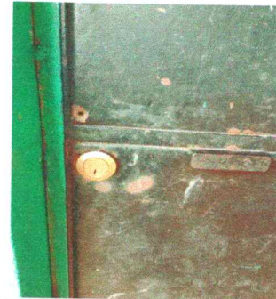
Foto 4: Sustrucción de puertas de metal a puertas de metal de 1 metro de ancho
