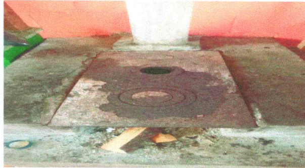
Foto 14: Mantenimiento y sustitución de estufa rural (completa) incluye chimenea y plancha de metal
