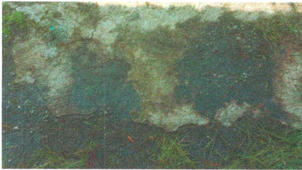
Foto 9: Reparación de planchas de concreto de patio
