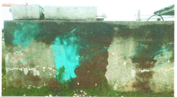
Foto 12: Reparación y mantenimiento de sistemas/ depósitos de agua
